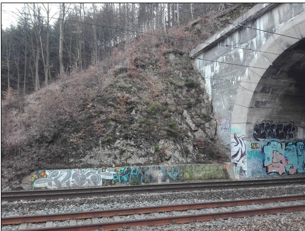
Obr. č. 5 - pohled na skalní stěnu nad zárubní zídou, stěnu bude vhodné zakrýt ochrannou ocelovou sítí v rámci sanace skalních svahů či v rámci sanace tunelu č. 4
